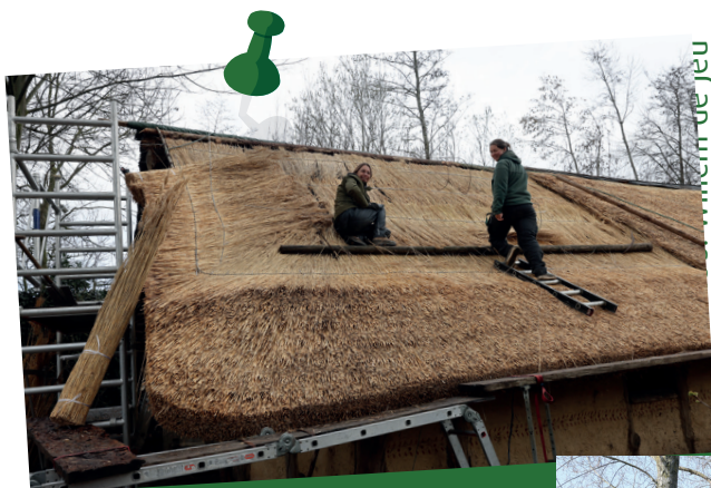
Nieuw dak voor de LBK boerderij
