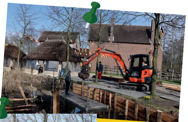
Aanleg nieuwe kade
